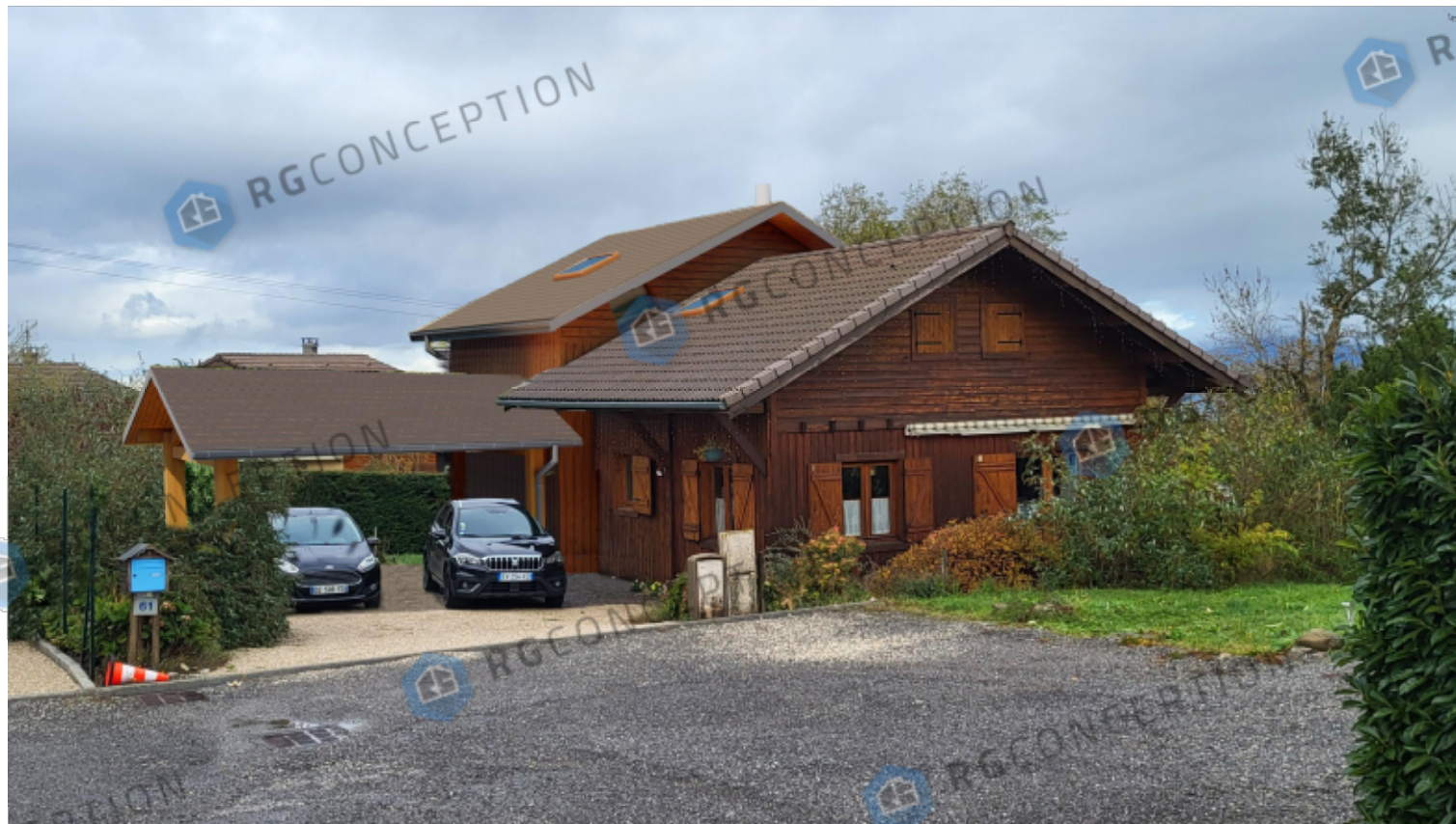
Insertion - coté Sud-Est - Suivant photo n°1
